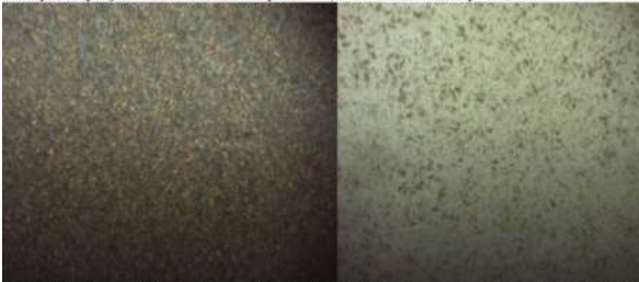
Placa expuesta en AltoNorte- Acero A36 presenta corrosión uniforme v en toda la probeta
