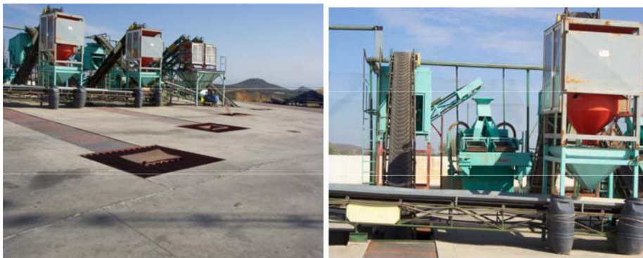
Figura 10.- Instalación para la recepción, lavado y pesado de
