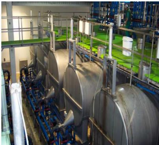
Figura 22.- Depósitos de oxidación de acero inoxidable
